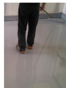
Le système **4010 / 4013 - 4015** est dédié à la réalisation de sol en époxy autolissant teinté ou transparent. Il est 100% extrait sec, une fois durci il est sans odeur et ne contient pas de solvants.
